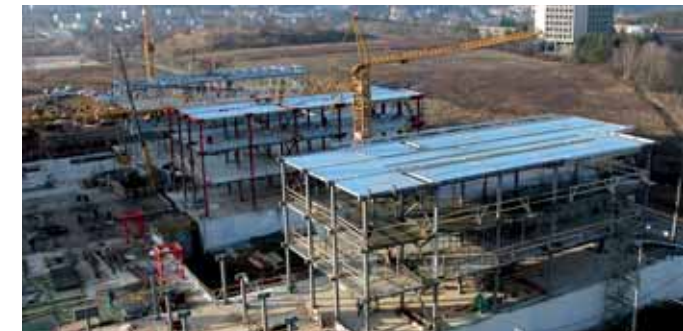
Výstavba ILBIT, leden 2005
