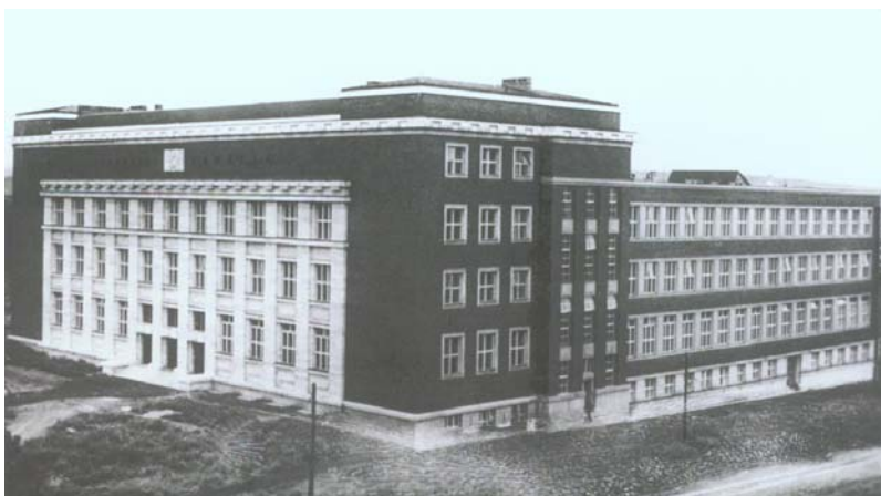
Právnická fakulta jediná realizovaná stavba univerzitního města na Kraví hoře – 1933
